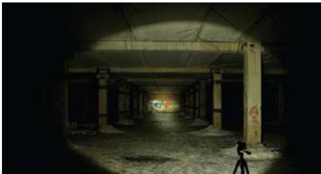
Расстояние до стены — 50 м.
